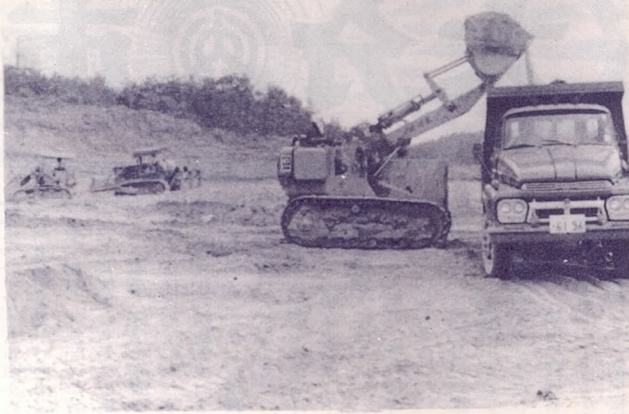
建設工事の進む横尾浄水場
