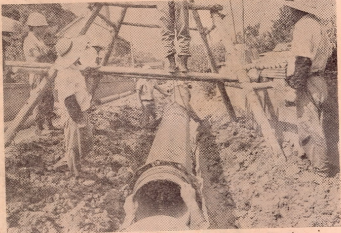
写真=大分・鶴崎を結ぶ直径400ミリの送水管敷設工事
