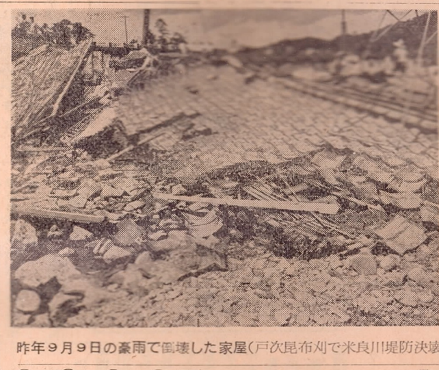
昨年9月9日の豪雨で破壊された家屋(戸次市布刈で米良川堤防決壊)
