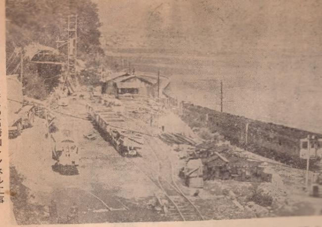
写真：日豊本線復線化の高崎山トンネル工事
