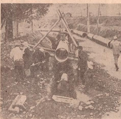
写真 = 森岡尾羽田の配水管布設工事
