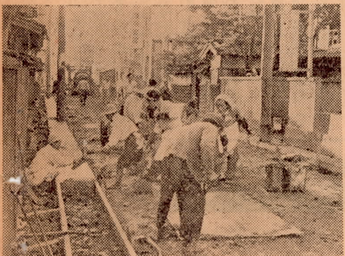
小物座町の舗装工事
