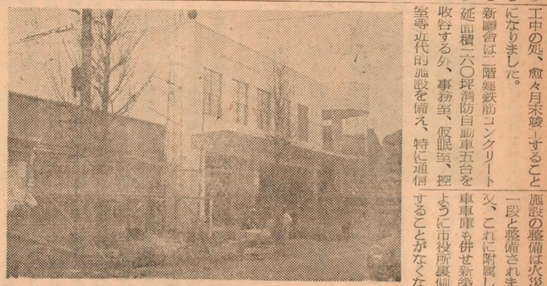
(消防本部新庁舎)
