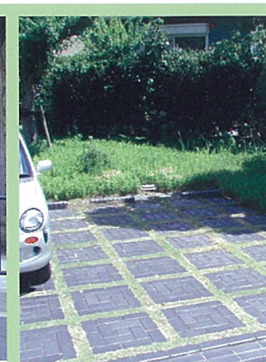
緑化された駐車場の例
