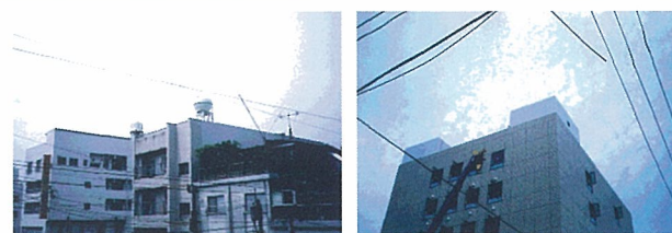
屋上設備が隠されていない建物の例
