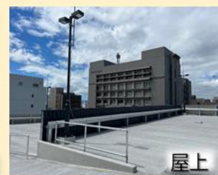
スロープ車路
