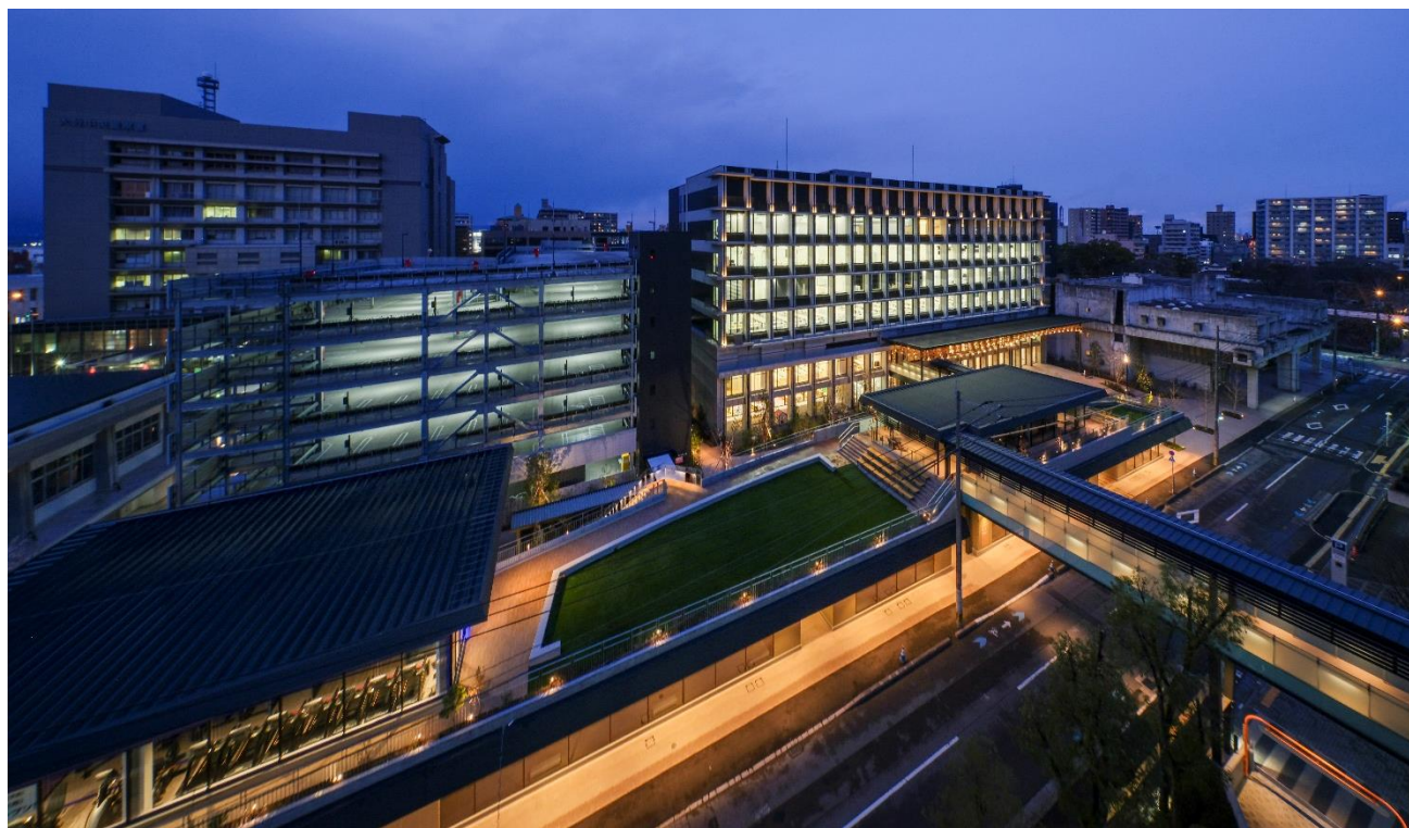
荷揚複合公共施設
