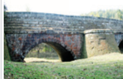
「明治大分水路橋」
