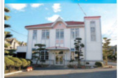
「フジボウテキスタイル株式会社 事務棟」
