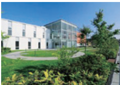
屋上緑化（ホルトホール大分）
