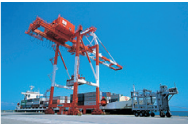
大分港大在コンテナターミナル
