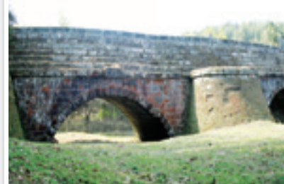
「明治大分水路橋」
