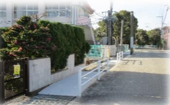
通学路安全施設整備 (水路の蓋掛け等)
