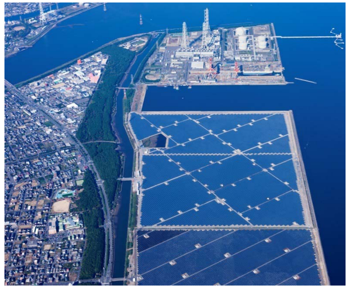
【現在の埋立造成地】
