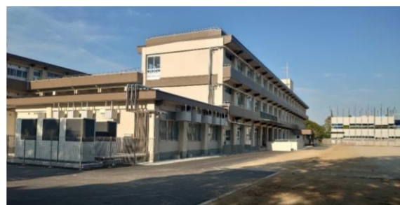
写真：長寿命化改修工事を終えた横瀬小学校校舎
