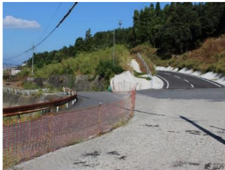
写真：曲敷戸団地線の付替工事終了箇所
