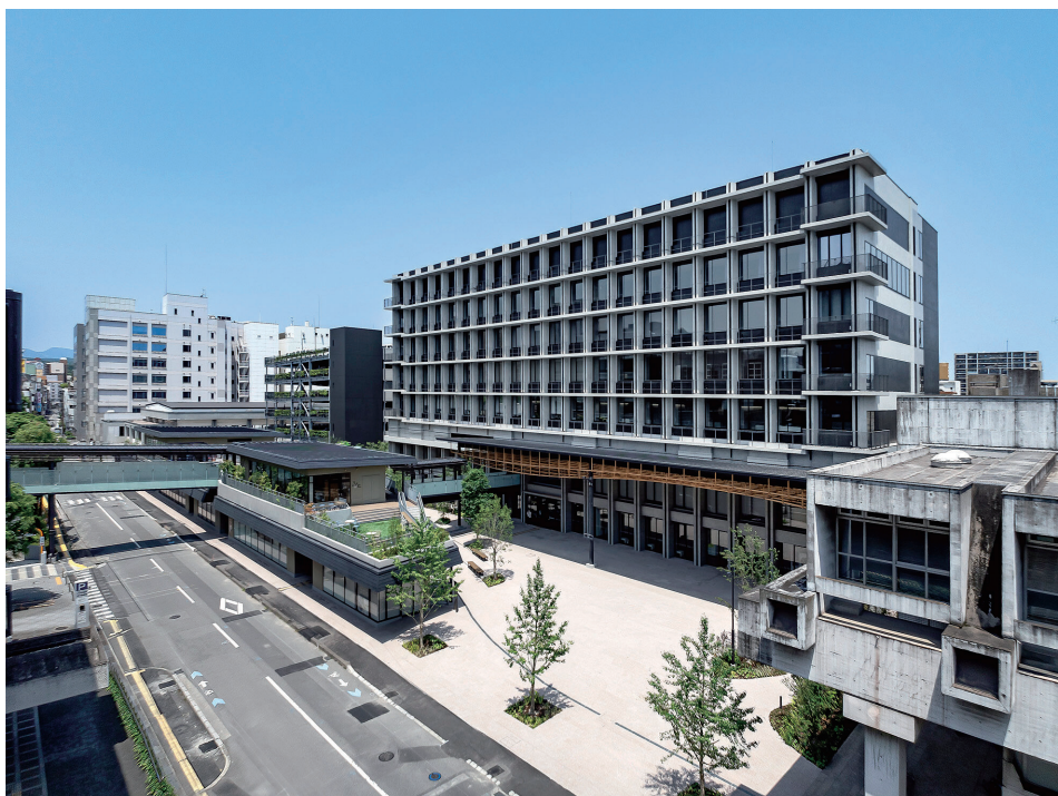
荷揚複合公共施設
