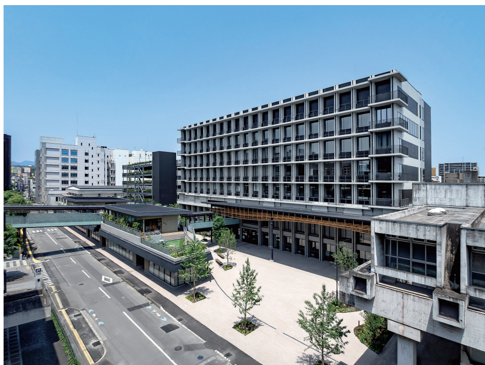
荷揚複合公共施設
