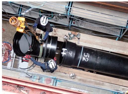
水道基幹管路耐震化
