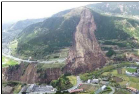
平成28年熊本地震阿蘇大橋地区の大規模土砂災害 [ 出典：国土交通省作成「総力戦で挑む防災・減災プロジェクト」 ]
