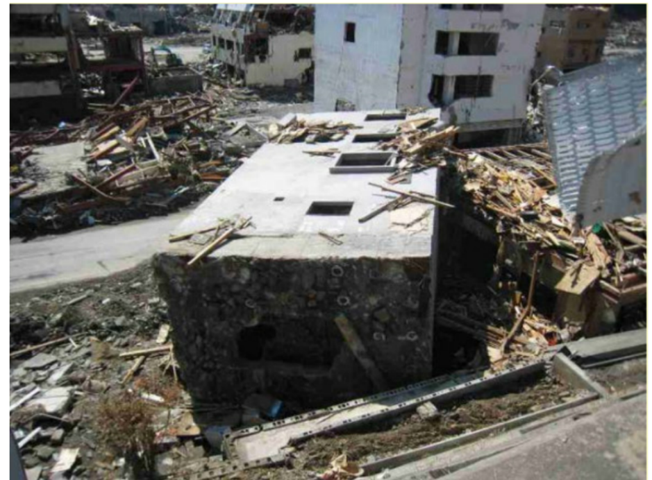
津波により転倒した鉄筋コンクリート造の建物
