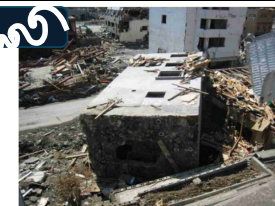
津波により転倒した鉄筋コンクリート造の建物 出典：国土技術政策総合研究所 (津波避難ビル等の構造上の要件の解説)
