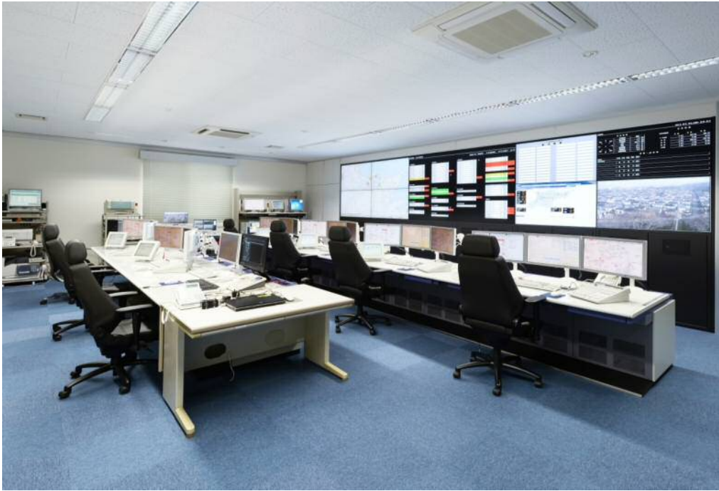
大分市消防局 通信指令センター
