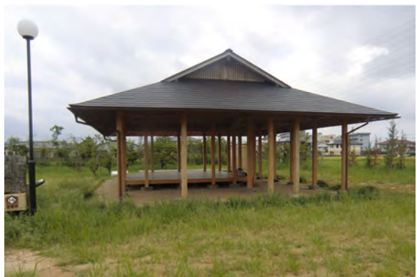
徳島県勝瑞館跡 主建物跡を便益施設として復元
