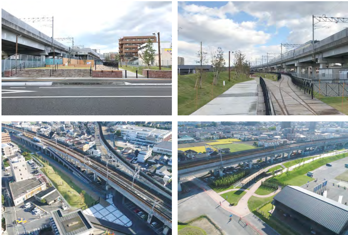
図 3-13 線路敷ボードウォーク広場整備状況
