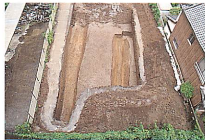
SD201・SD203完掘状況 (調査区南端)
