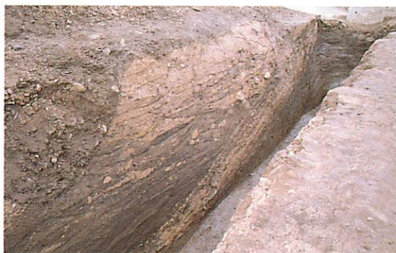
H12年度調査 土壘 写真 (古段階)
