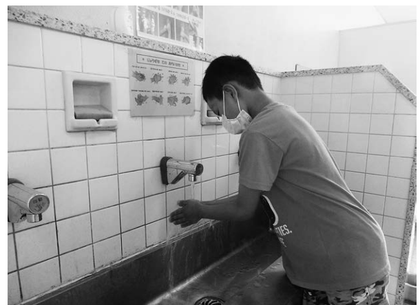
小中学校自動水栓整備事業
