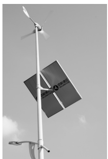
風力・ソーラー発電の両方の機能を持つエコ街路灯
