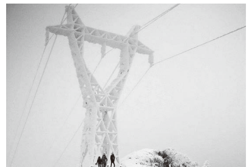
三峡ダムへの電力線路
