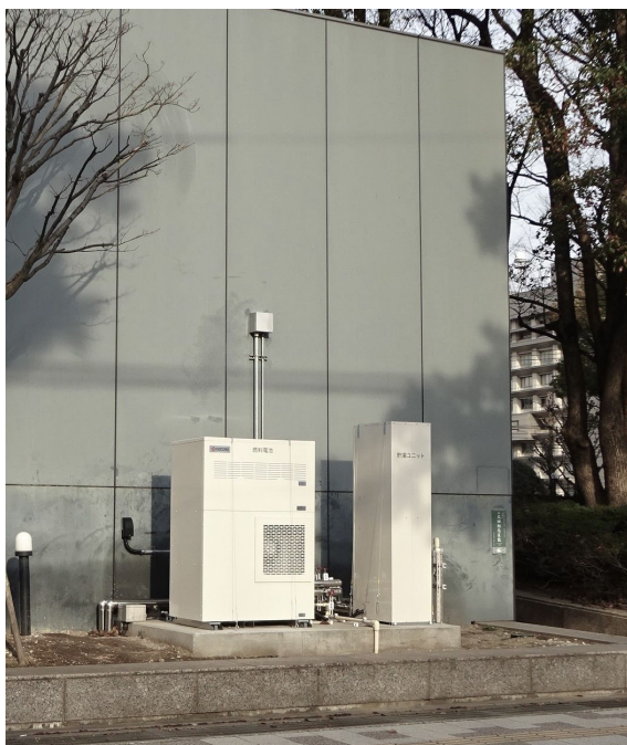
市有施設に導入した業務用燃料電池
