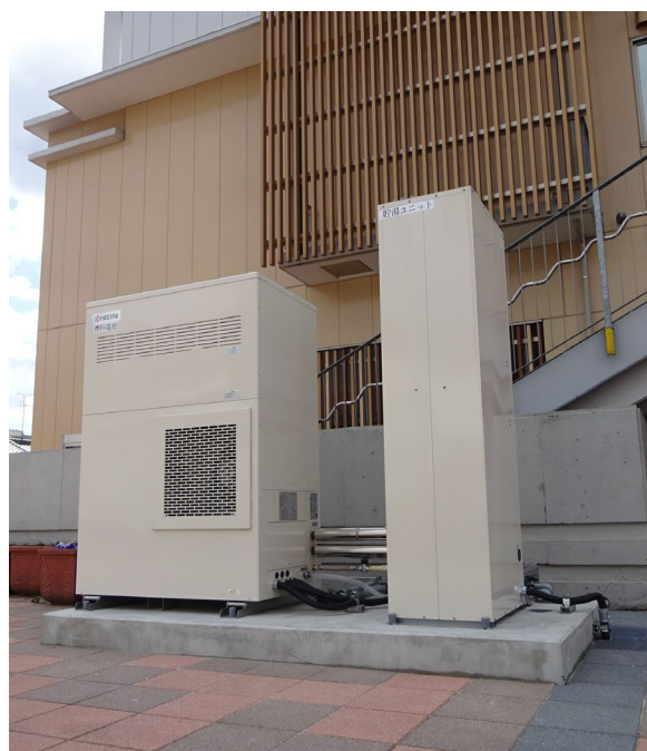
市有施設に導入した業務用燃料電池
