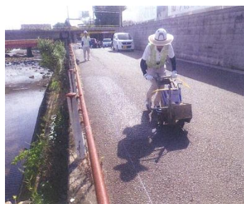
プライマー散布状況
