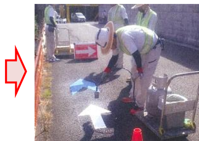
溶融式路面シート加熱状況
