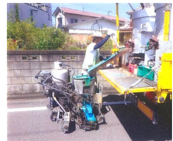
(参考：従来施工)
