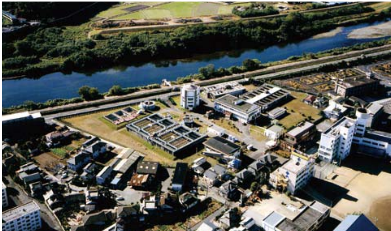
えのくまじょうすいじょう えのくま浄水場 (1日にプール (300m 3 ) 193はい分の) (58,000m 3 ) 水を作ることができます
