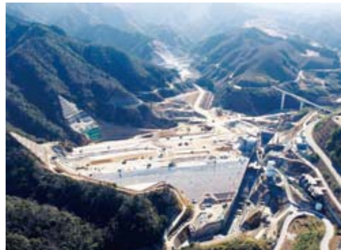
ななせダム建設工事
