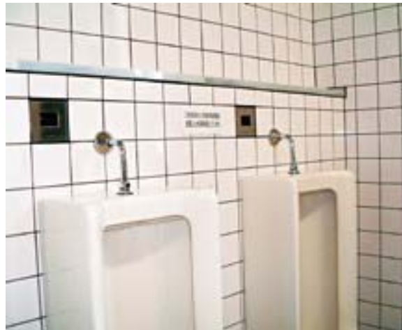
処理水を市役所第2庁舎や保健所内の トイレの洗浄水として
