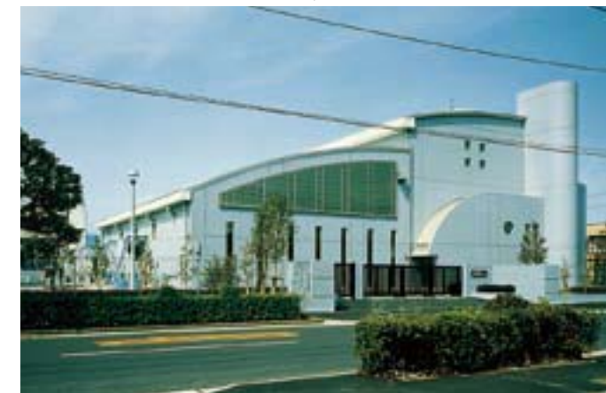
うすいはいすい 雨水排水ポンプ場
