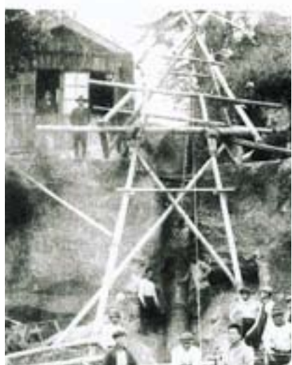
配水管取り付け工事 (昭和2年)
