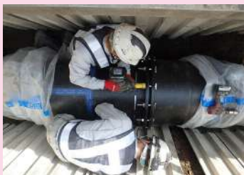
水道管の更新
