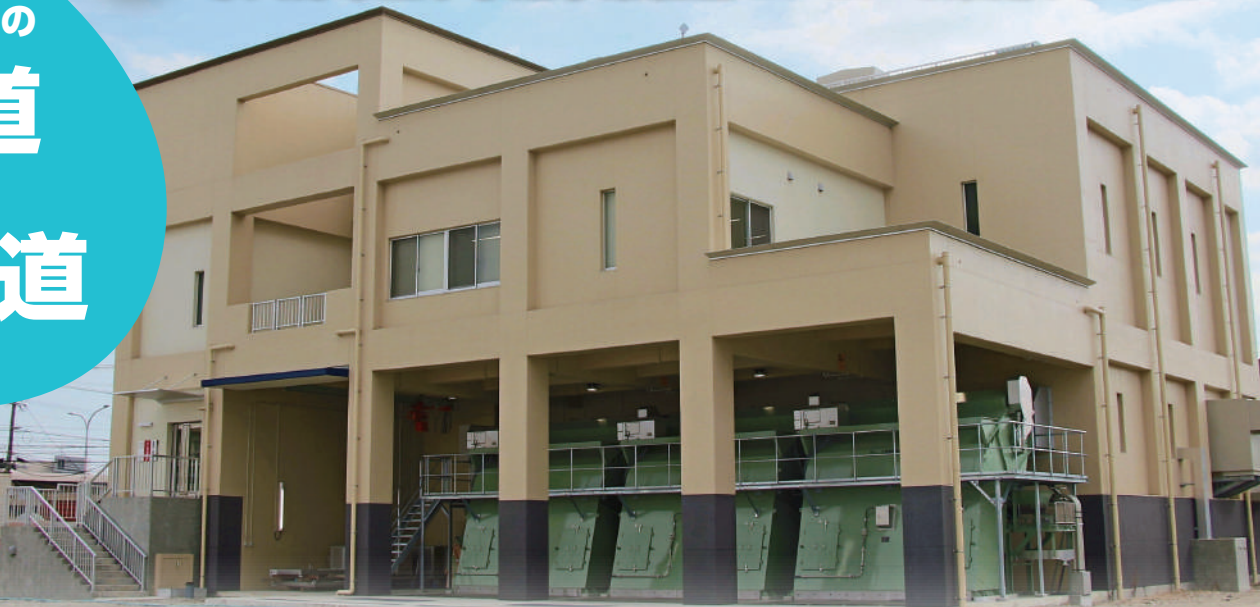
片島雨水排水ポンプ場
