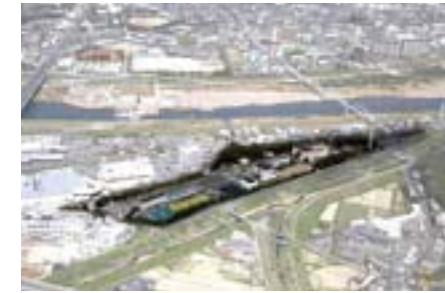
③ 松岡水資源再生センター
