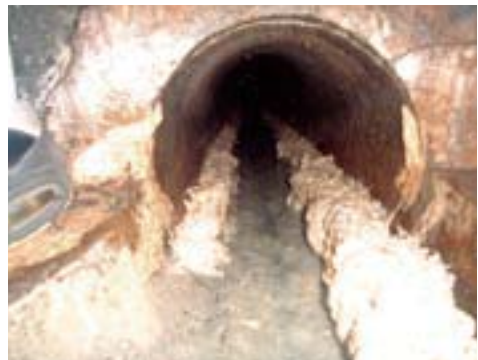
ラード（油）が付着した下水道管
