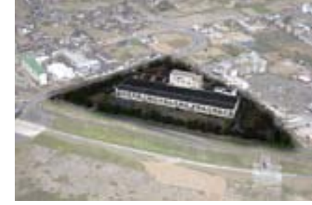
④ 原川水資源再生センター
