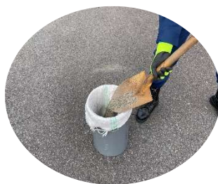
土のう袋を被せて 土砂を入れます。
