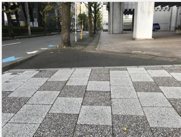
図 3-41 市道荷揚6号線と荷揚4号線の舗装の材質の違い
