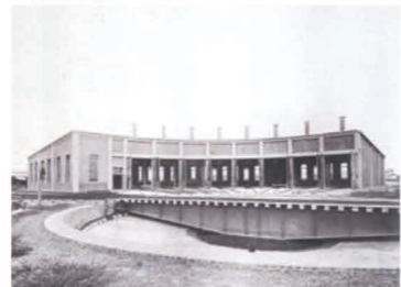
「大分停車場構内扇形機関車庫写真帖」 (竣工当初の大分駅機関庫) 大分市歴史資料館所蔵
