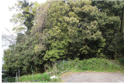
北西張り出し部（密生する樹木）
