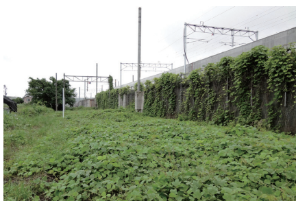
新設されたJR日豊本線高架と旧軌道敷 (平成24年6月)
