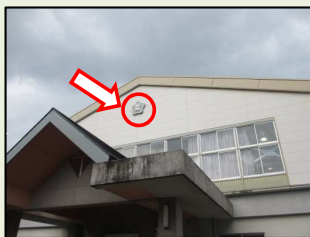
体育館南側入口
