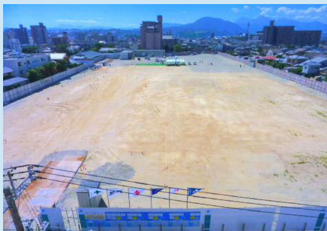
(建設工事に着工した碩田中学校地)
