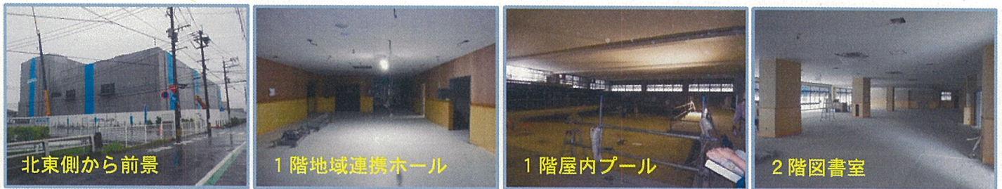
進捗状況写真
