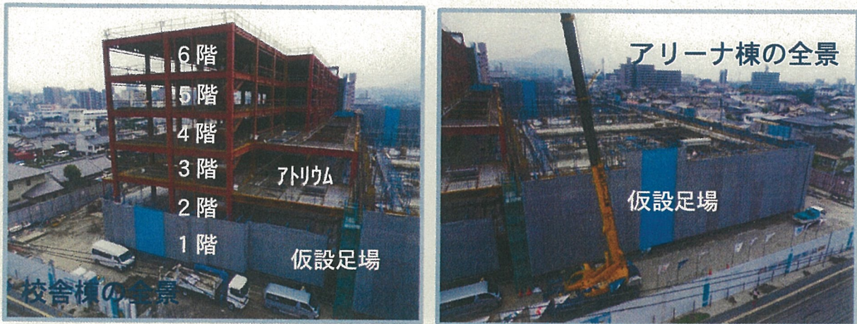
進捗状況写真
