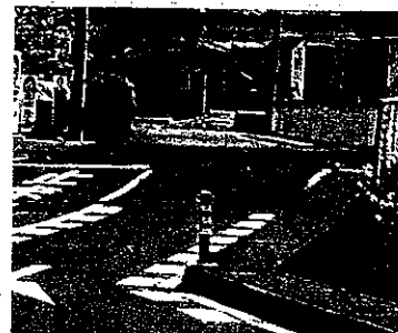
大在駅東側踏切 / 反射棒設置
