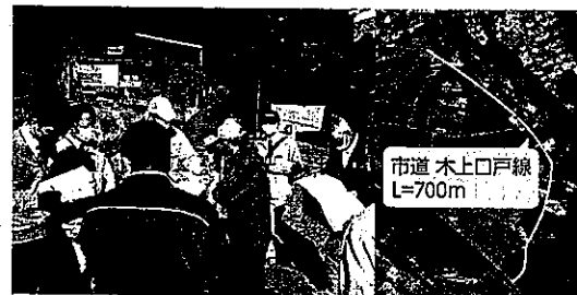
市道 木上戸線の現地調査と航空写真で見た木上地区
