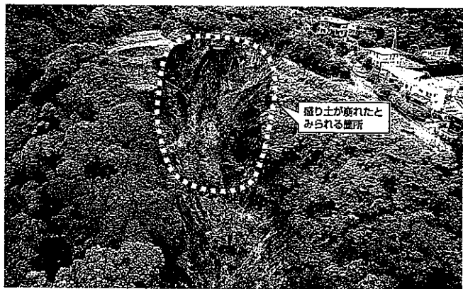
熱海の土砂崩れの原因は届出以上の残土の搬入をした業者の違法行為と、それを見過ごした行政（県）の怠慢です。
