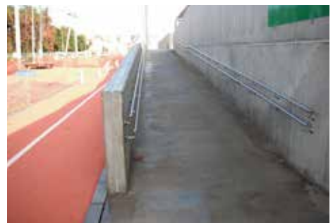
都市公園のバリアフリー化 （駄原総合運動公園のスロープ）
