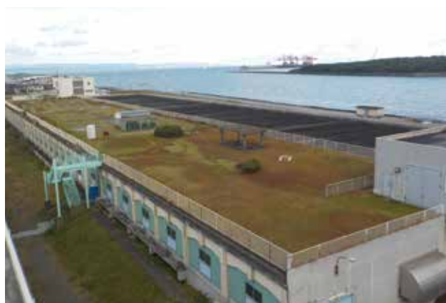
弁天水資源再生センターの屋上緑化
