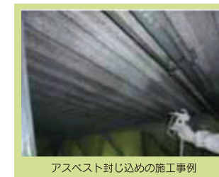
アスベスト封じ込めの施工事例
