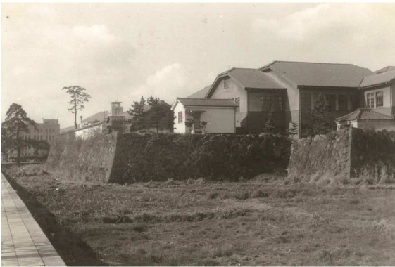
東之丸南東隅櫓部と東三重櫓台付近
