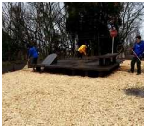
間伐材ウッドチップの敷き詰め作業
