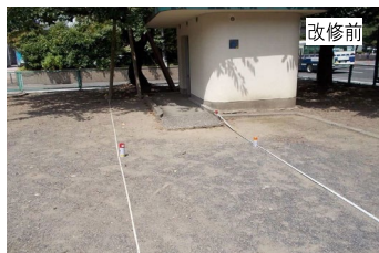
通路の改修（大手公園）
