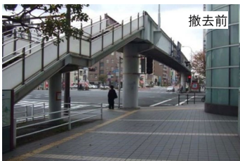
歩道橋の撤去（国道 197 号）
