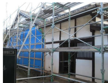
災害復旧工事中の毛利空桑旧宅(令和4年)
