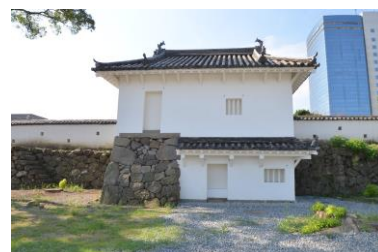
半解体修理が完了した宗門櫓 (R2)
