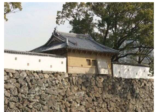
宗門櫓(修理中) (平成30年(2018)2月撮影)
